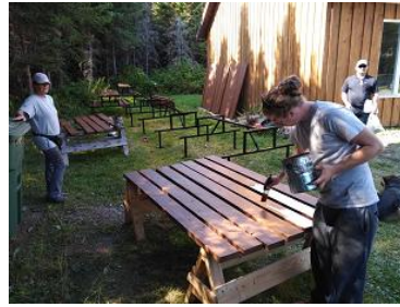
Gracia / Mathieu: Fabrication de nouvelles tables. Building new picnic tables
