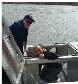
Sylvain /David – Installation de la trappe rotative sur la riv. Matapédia – Matapédia Smolt wheel installation
