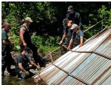
Christine with staff and DNRED workers during barrier installation. Christine et travailleurs du MDRNE durant l'installation de la barrière.
