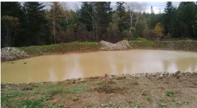
**Figure 107: Exemple de trappe à sédiments**
